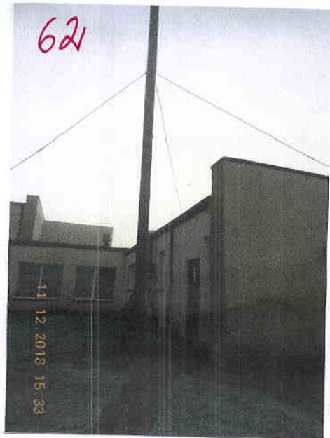
METĀLA DŪMEKIS BEZ IZOLĀCIJAS AR APJOMTĀM KORROZIJAS PĀTINĒM.
