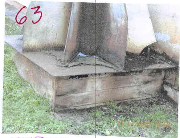
METĀLA DŪMEKIS BEZ IZOLĀCIJAS AR APJOMTĀM KORROZIJAS PĀTINĒM.
