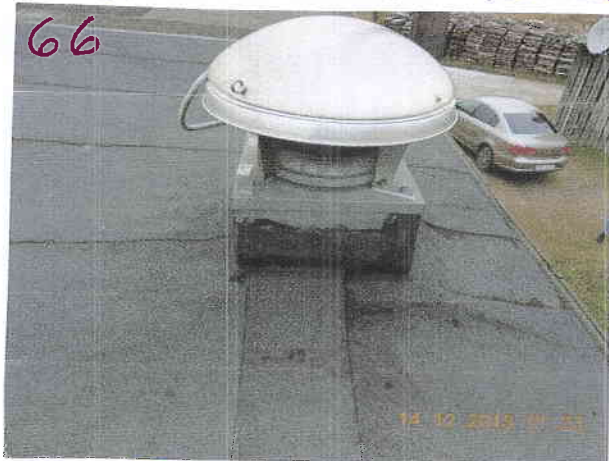
VIRTUVĒ UN VEĻAS MAZGĀTUVĒ PIESPIEDU VENTILĀC. SISTĒMA.
